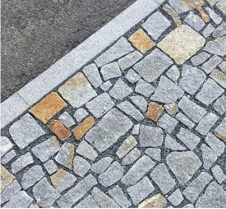
žulové odštěpky v obrubě, zdroj internet
